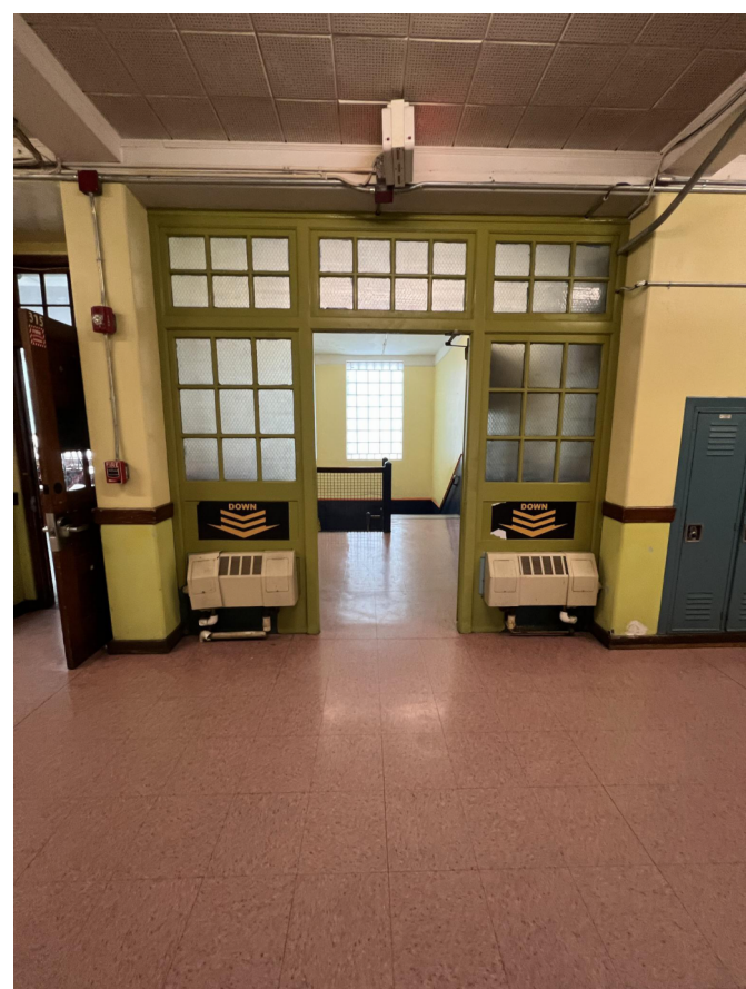
PHOTO 7 - STAIR A DOOR 300-A
