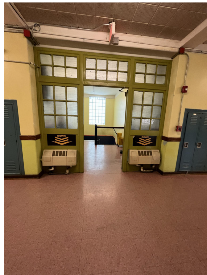
PHOTO 3 - STAIR B DOOR 300-B
