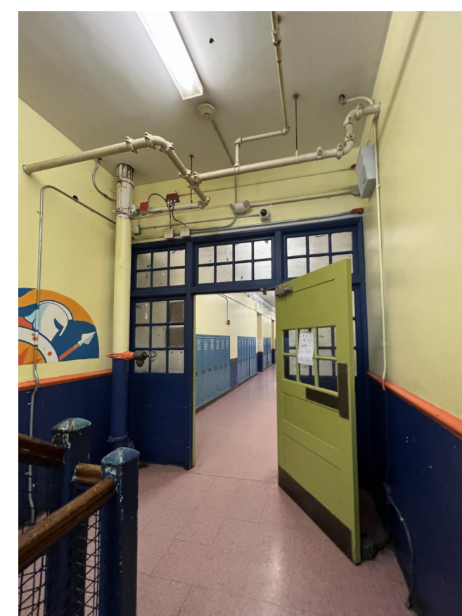
PHOTO 8 - STAIR A DOOR 200-A
