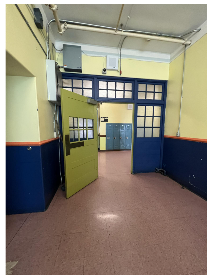
PHOTO 8 - STAIR A DOOR 300-A
