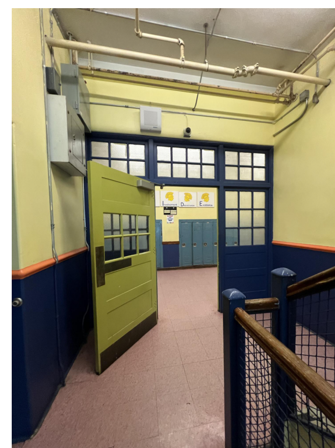
PHOTO 6 - STAIR C DOOR 200-C
