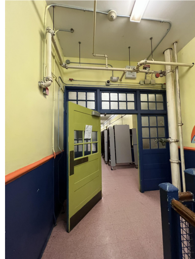
PHOTO 2 - STAIR D DOOR 200-D
