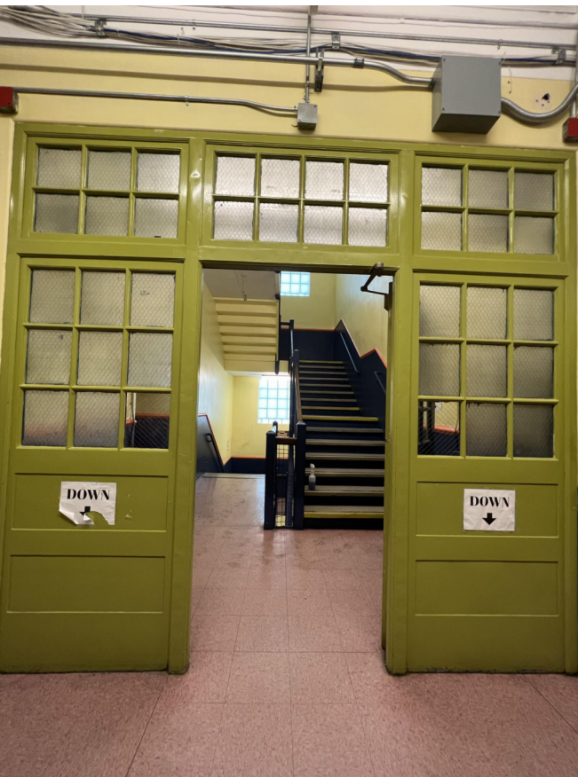
PHOTO 3 - STAIR B DOOR 200-B
