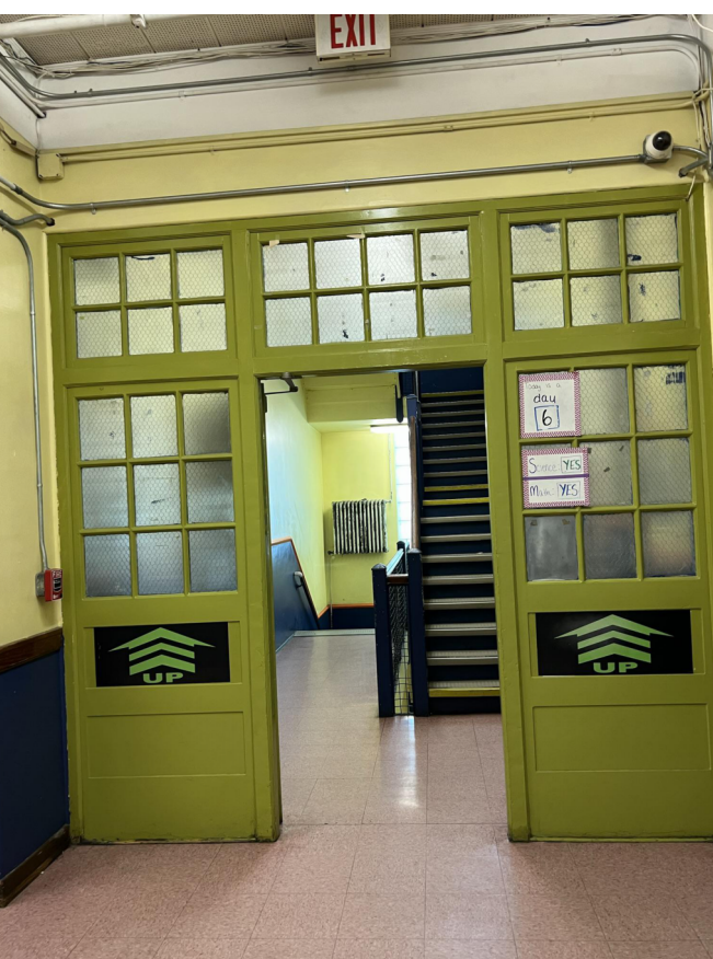
PHOTO 7 - STAIR A DOOR 200-A
