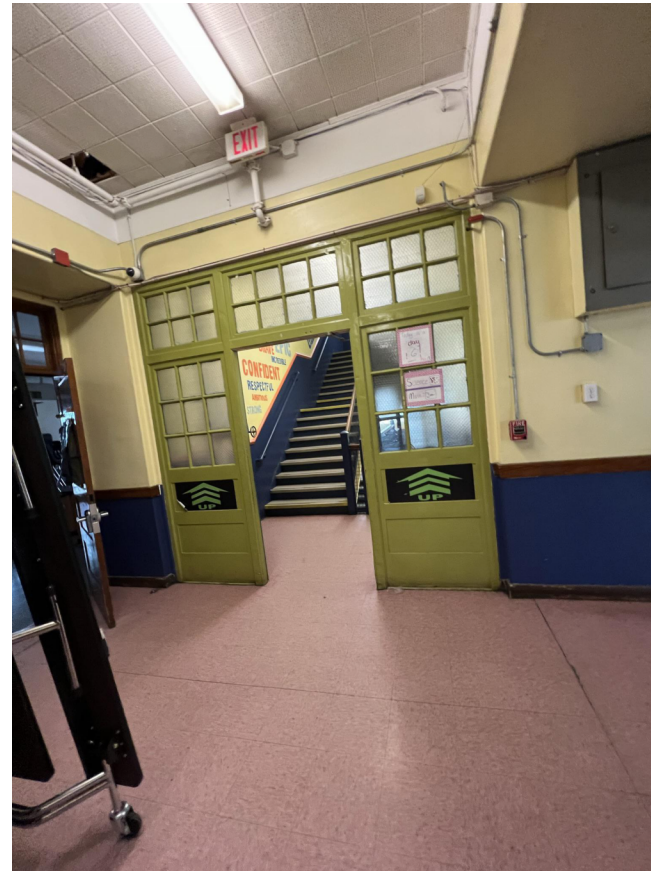
PHOTO 1 - STAIR D DOOR 200-D
