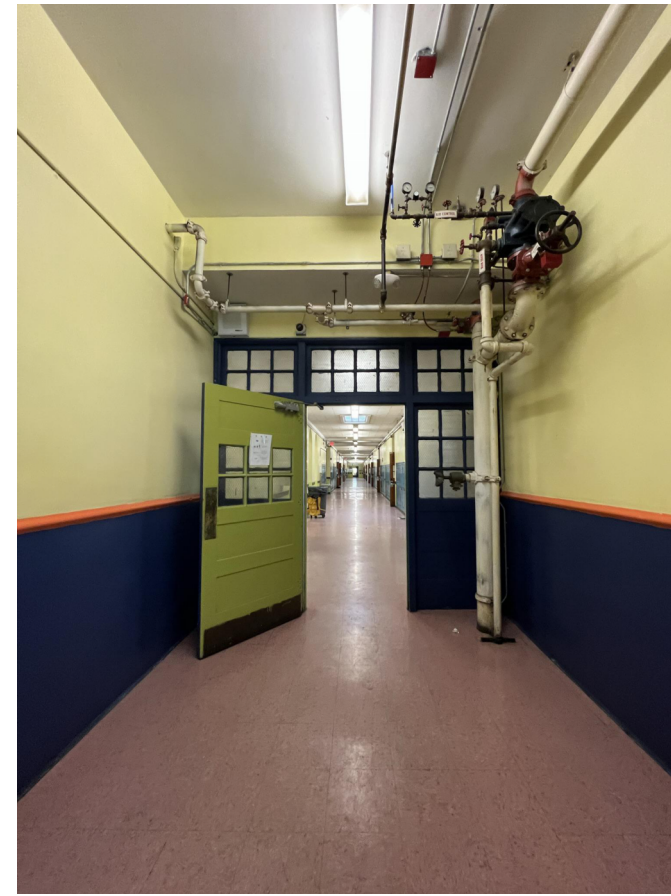
PHOTO 2 - STAIR D DOOR 300-D
