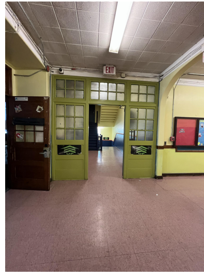
PHOTO 1 - STAIR D DOOR 300-D
