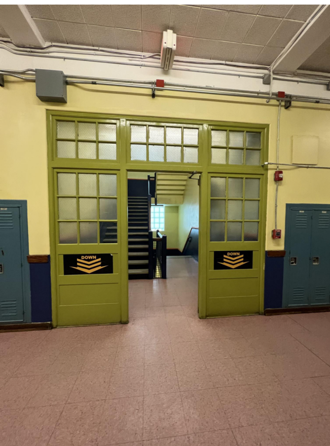
PHOTO 5 - STAIR C DOOR 200-C
