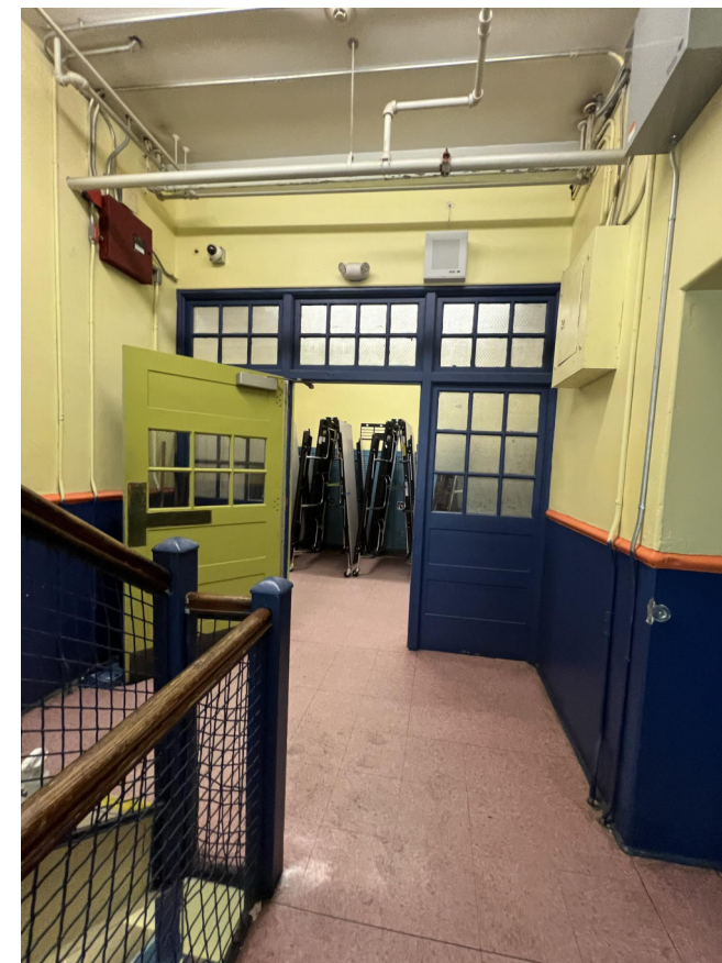
PHOTO 4 - STAIR B DOOR 200-B
