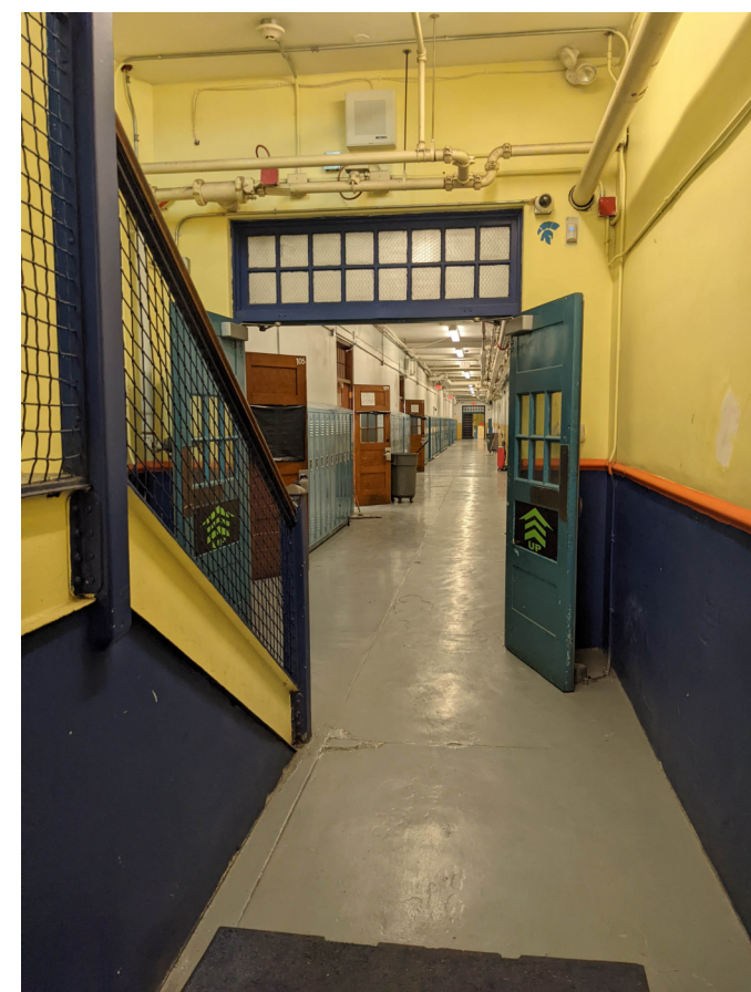
PHOTO 8 - STAIR D DOOR 100-D
