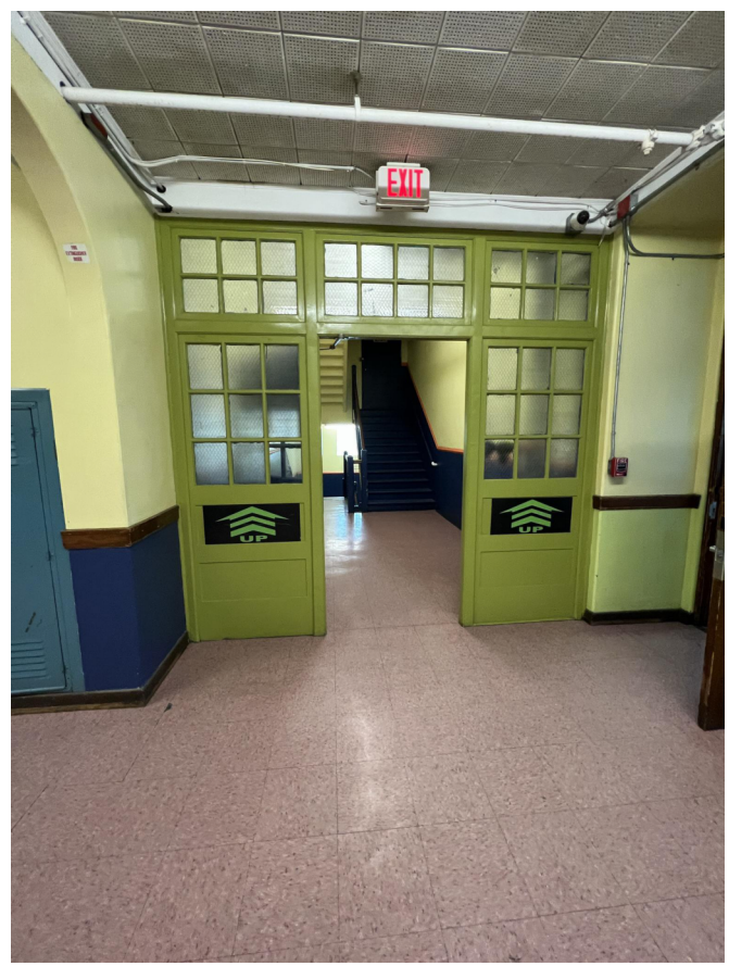
PHOTO 5 - STAIR C DOOR 300-C
